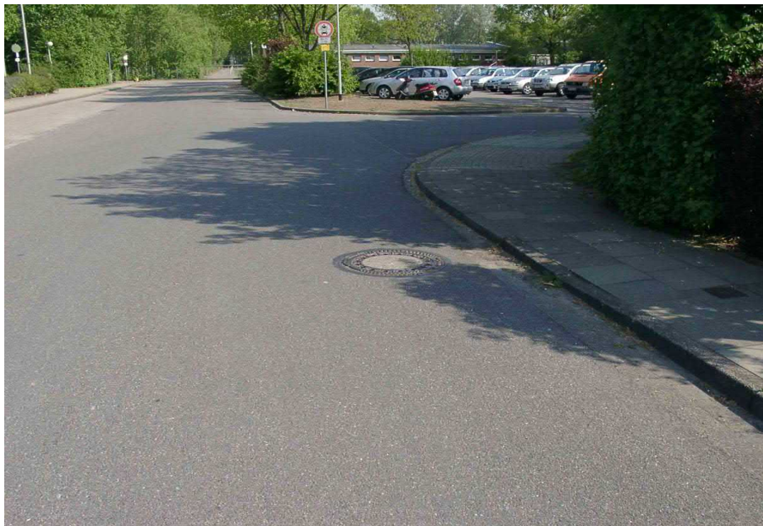
Einleitungsstelle in Richtung Norden
