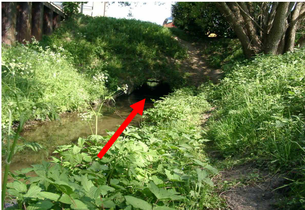
Einleitungsstelle in Richtung Westen
